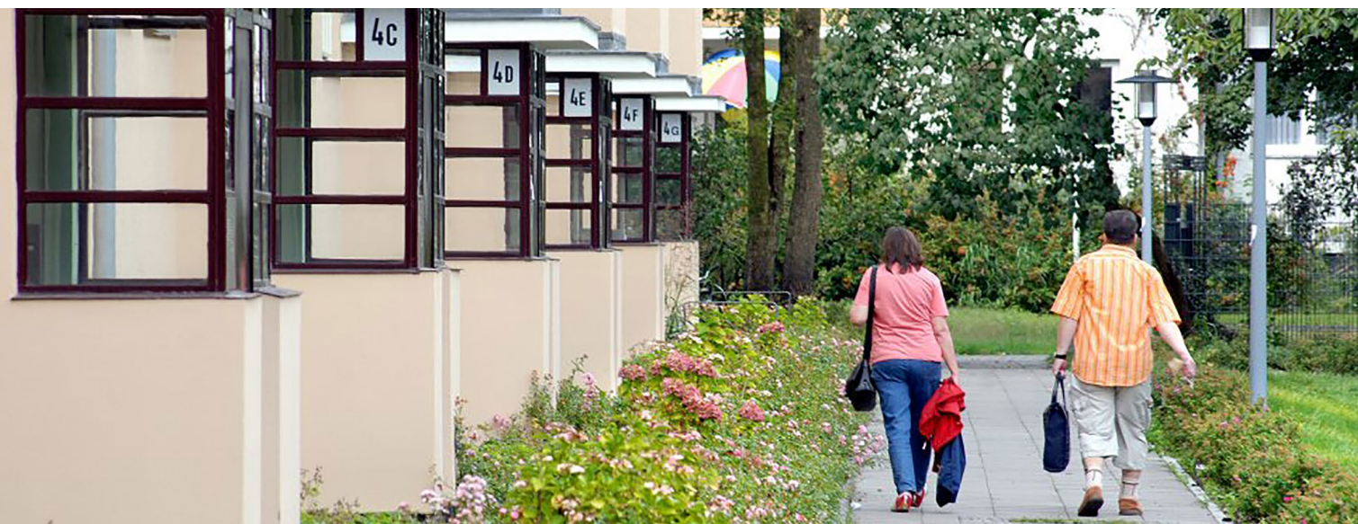
Sanierte Windfänge an Wohnhäusern am Burscheider Weg in der Siedlung Haselhorst sorgen für geringere Wärmeverluste
