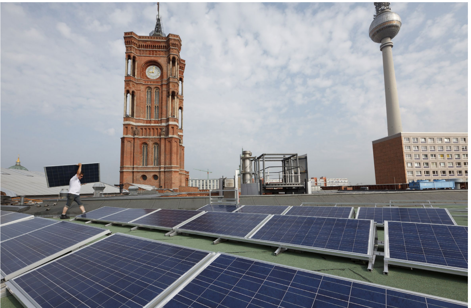
Montage des Solardachs auf dem Roten Rathaus
